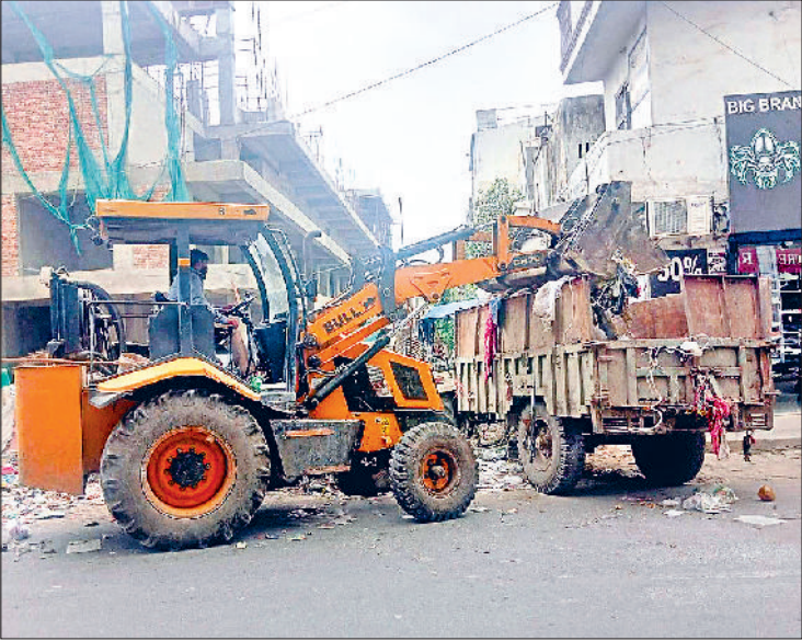
सोनीपत। संत निरंकारी भवन रोड पर बुलडोजर से कूड़ा उटाते कर्मचारी।
